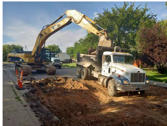
Monte Vista Waterline
