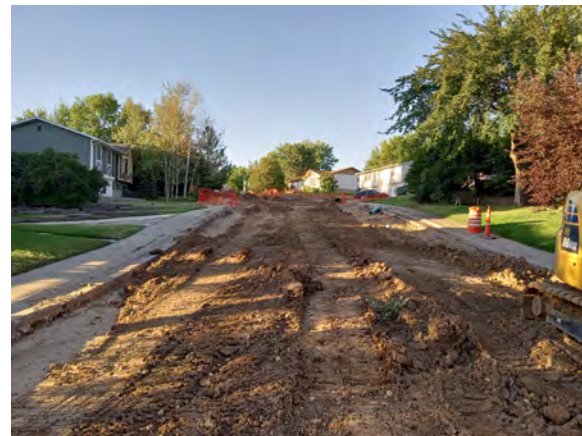
Monte Vista Waterline
